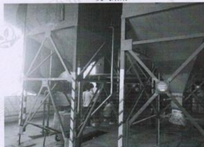
锅炉废气采样
